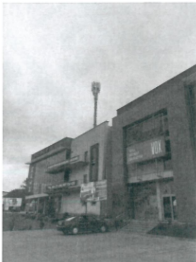
Widok obiektu wraz z zainstalowanym zespołem antenowym
