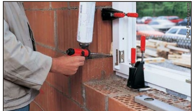
Zawód montera wymaga precyzji i dyscypliny pracy
